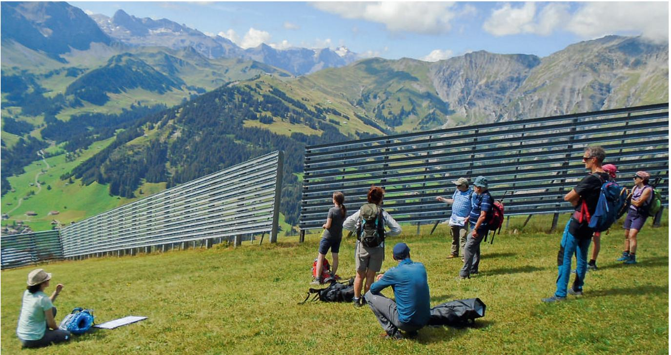
Lawinenschutzwand, die der Verfrachtung von Schnee dient: Durch die Öffnungen strömt Wind, sodass der Schnee an Stellen geblasen wird, wo er nicht zur Lawine werden kann.
