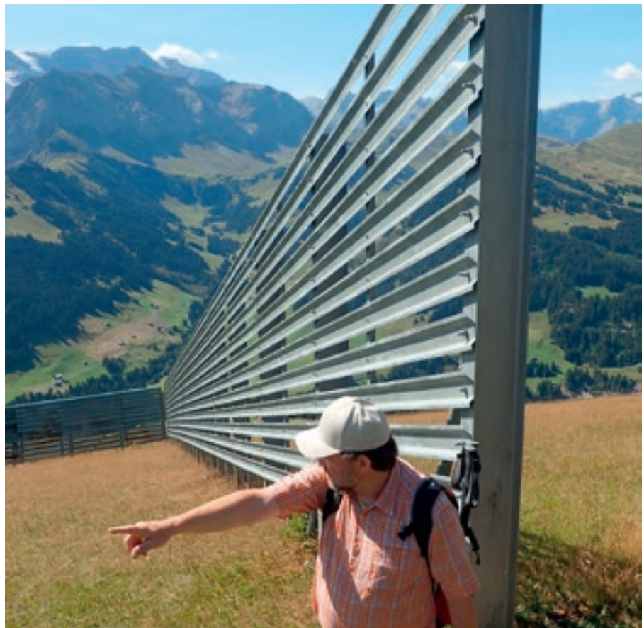
Der im Zickzack aufgebaute Tribschneezäun unterhalb des Schwandfälsplatz. Die reduzierte Windgeschwindigkeit führt zur gezielten Ablagerung von Tribschnee.
